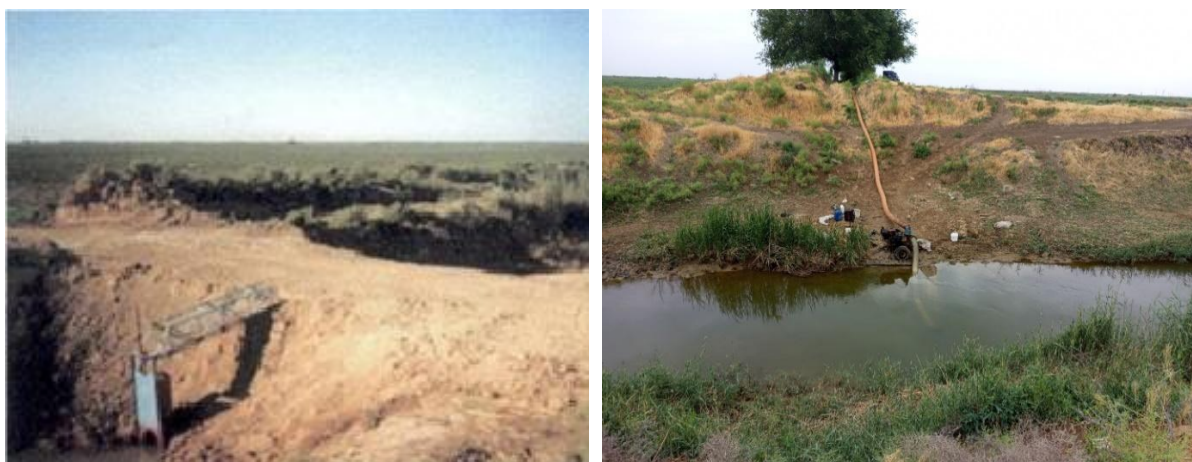
Рисунок 3 – Шлюзование коллекторно-дренажной сети для поддержания уровня воды и использование машинного водоподъема для орошения орошаемых земель в Голодностепском массиве орошения бассейна р. Сырдарья
